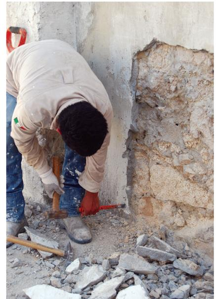
FIGURA 4. Eliminación de gruesas capas de aplanado de cemento que propiciaron que la humedad encapsulada disgregara algunos componentes del núcleo de los muros (Fotografía: Luis Fernando Guerrero, 2015).
