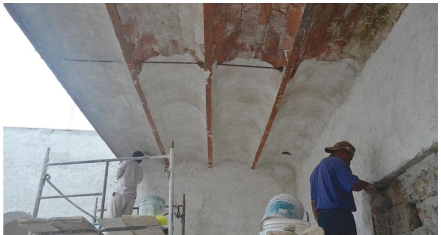
FIGURA 8. Aplicación de aplanados en muros y bajo las bóvedas catalanas (Fotografía: Geiser Gerardo Martín, 2015).
