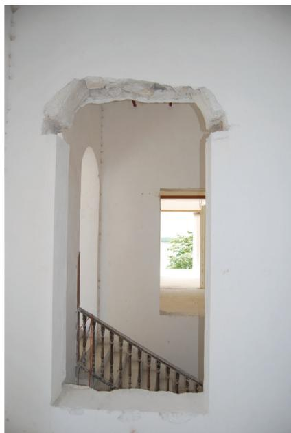
FIGURA 9. Colapso de la platabanda que se apoyaba sobre el dintel de madera (Fotografía: Luis Fernando Guerrero, 2015).
