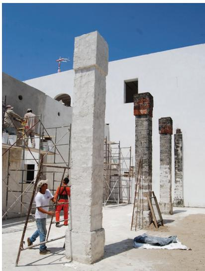
FIGURA 12. Culminación de los revoques de cal y arena antes de la reintegración del techo de armadura y teja de la antigua área de almacenamiento (Fotografía: Luis Fernando Guerrero, 2015).
