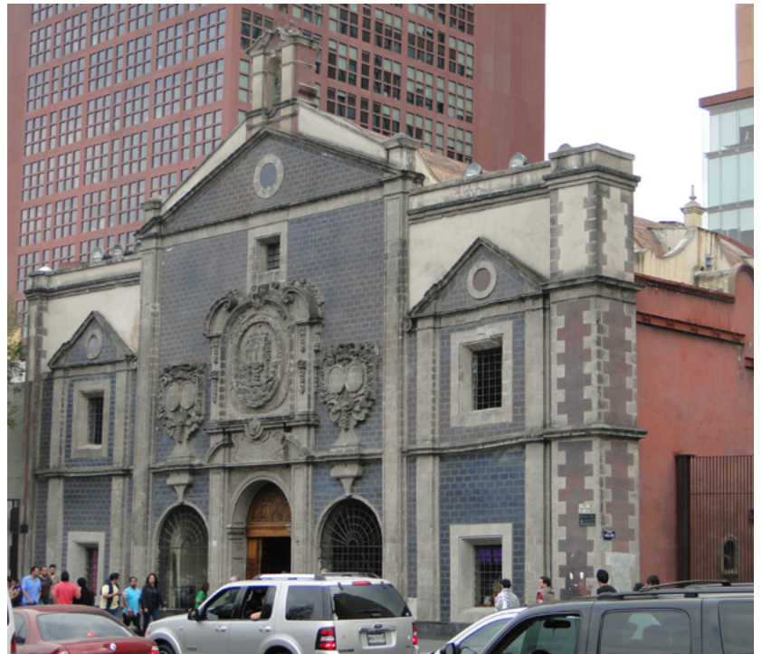
FIGURA 1. Fachada principal del convento de Corpus Christi, Ciudad de México (Fotografía: Ivan San Martín, diciembre de 2006).
